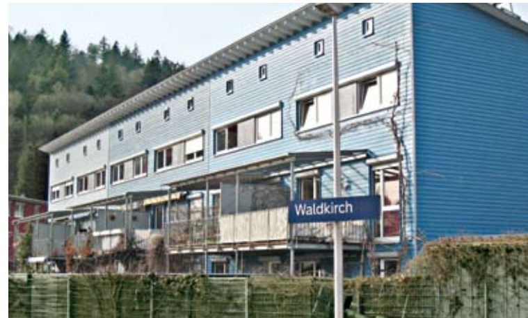
Zwölf Stadthäuser der Baugemeinschaft Gleis 3 in Waldkirch, Architekt: Klaus Wehrle.
